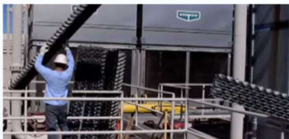
Ngâm hóa chất & xịt tẩm tần nhiệt Chemical soaking & High pressured water jet
