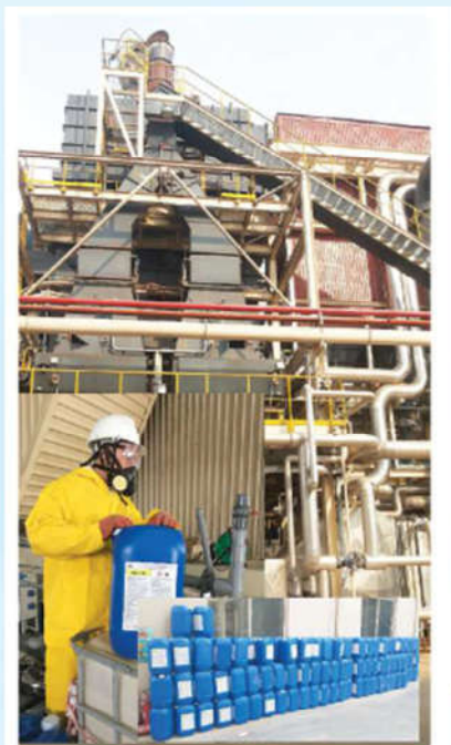
Vệ sinh lò hơi tại công trình Boiler cleaning at silte
