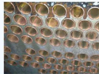
Dàn ngưng sau vệ sinh Condensor after cleaning
